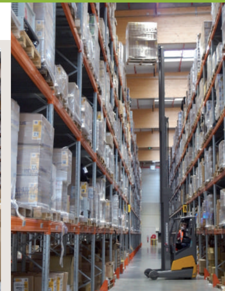
El tercer modo de almacenamiento se basa en estanterías convencionales de 13 metros de altura (10 metros útiles). El operador de la carretilla elevadora se hace cargo de las paletas situadas en lo alto y las deja a la altura del hombre para el recolector.
